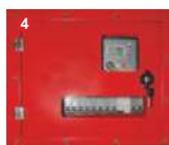
4 Металлическая дверь для повышения уровня IP контрольной панели
